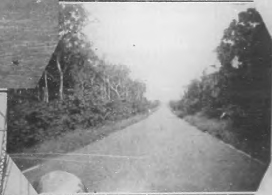
Un tramo recto de la carretera central, entre Jatabonico y Ciego de Avila.
