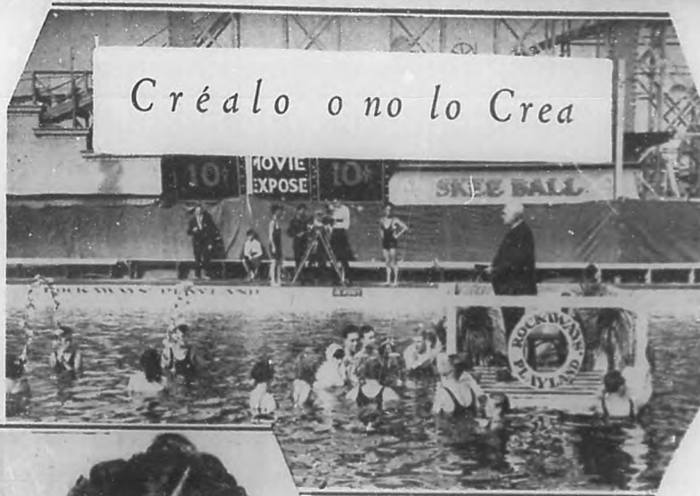
En Rockaway (Long Island) se efectuó esta boda dentro del agua. Los contrayentes fueron Al BRUMBAUGH y Elizabeth TAPPE. El único que no quiso mojarse fué el reverendo...
